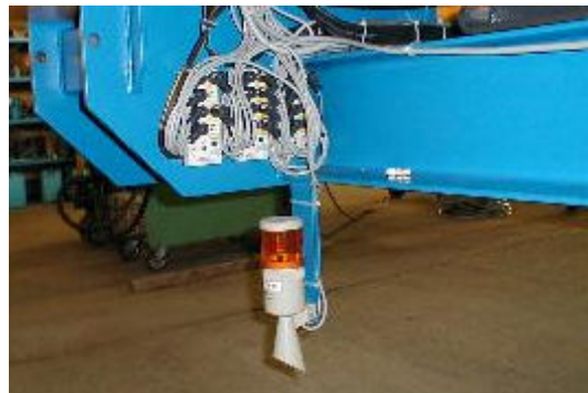
Holztrocknungsanlage Saalfelden Steuerung über dezentrale AS-Interface Konzeption
