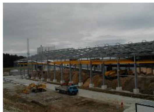
Stahl- und Anlagenbau für das Brennstofflager des Biomassen-Heizkraftwerkes Altenstadt bestehend aus:
